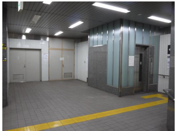
アスベスト飛散事故のあった六番町駅換気機械室前（2014年1月撮影）
